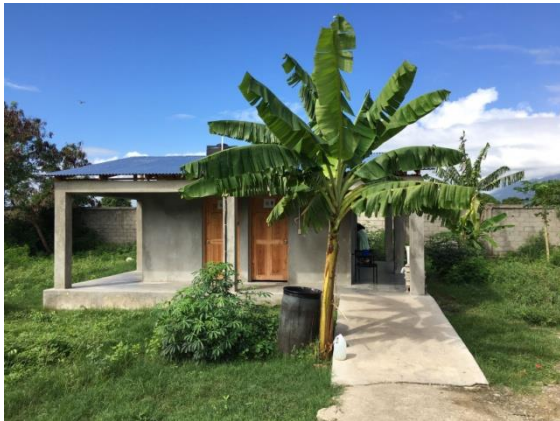
Die neuen sanitären Anlagen
